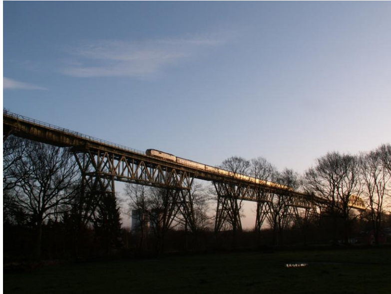
Abb. 2: Eisenbahnhochbrücke Hochdonn über den Nord-Ostsee-Kanal
